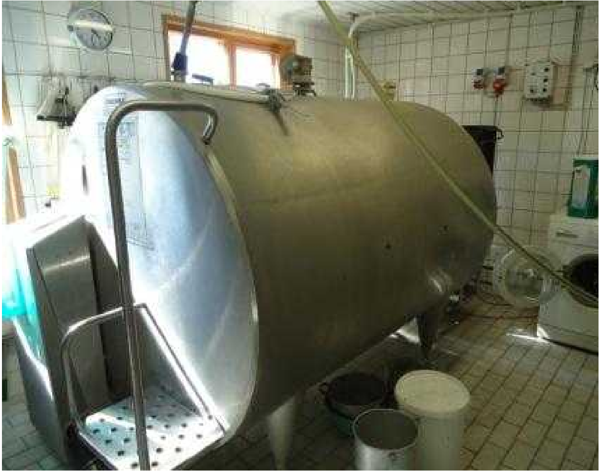
Tanki la kuhifadhia maziwa yanayokamuliwa kwa kupitia mifereji inayotoka wanakokamuliwa ng'ombe
